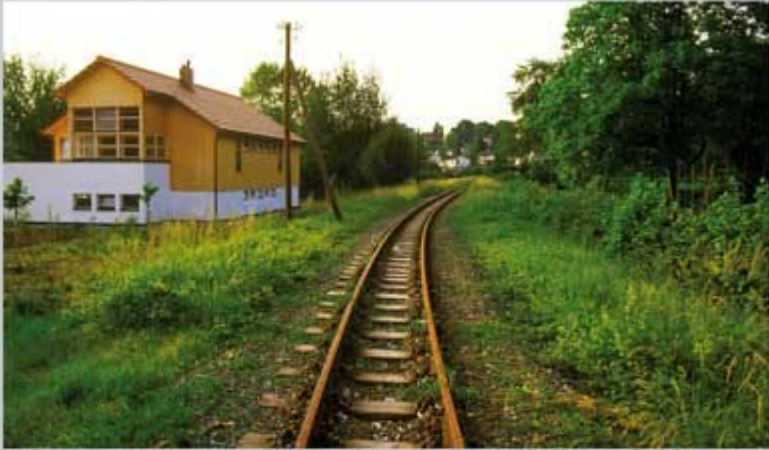
Zwischen der Haltestelle Rieden und dem Riedentunnel bei km 2,5, in der Nähe der Landstraße ist das Wohnhaus Kumenweg 8 in Bregenz. (in Fahrtrichtung Bregenz)
