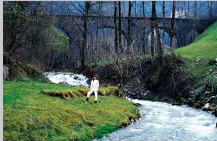
Das von Giovanni Ferdinando Bertolini erbaute Pfisterbachviadukt bei Andelsbuch km 25.
